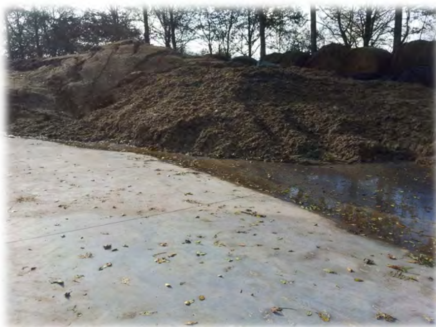
Figure 15 : Plateforme de stockage sans récupération des jus (source : Biogaz ingénierie)
