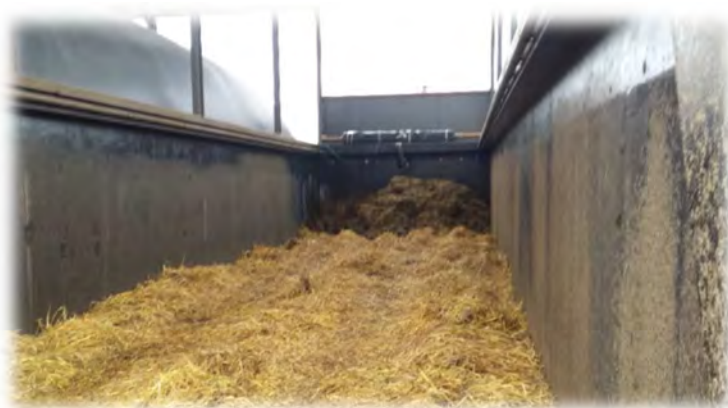
Figure 2 : Photographie d'un digesteur de type silo bâché ouvert (source photo : biogaz ingénierie)
