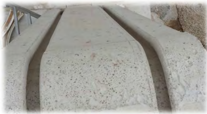
Figure 25 : Photographie d'un rail de fixation pour boudin gonflable (source : Biogaz ingénierie)
