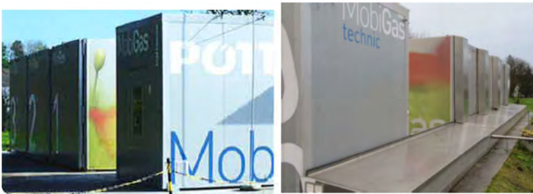
Figure 5 : Installation en voie sèche discontinue, concept caissons
