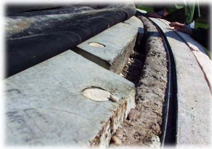
Figure 16 : Illustration de l'agression du béton due au soufre sur un digesteur (source : Biogaz ingénierie)
