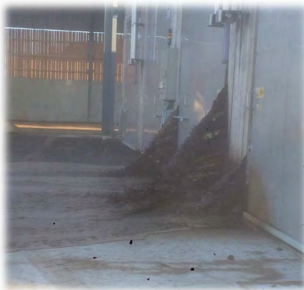
Figure 233 : Nappe perchée de percolât sortant de garages (source : Biogaz ingénierie)
