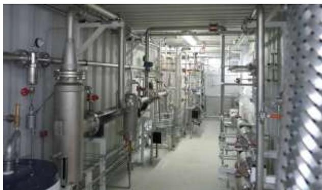
Dispositif d'épuration par membrane
