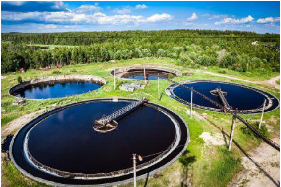
Figure 12 : Vue d'une station d'épuration de boues urbaines
